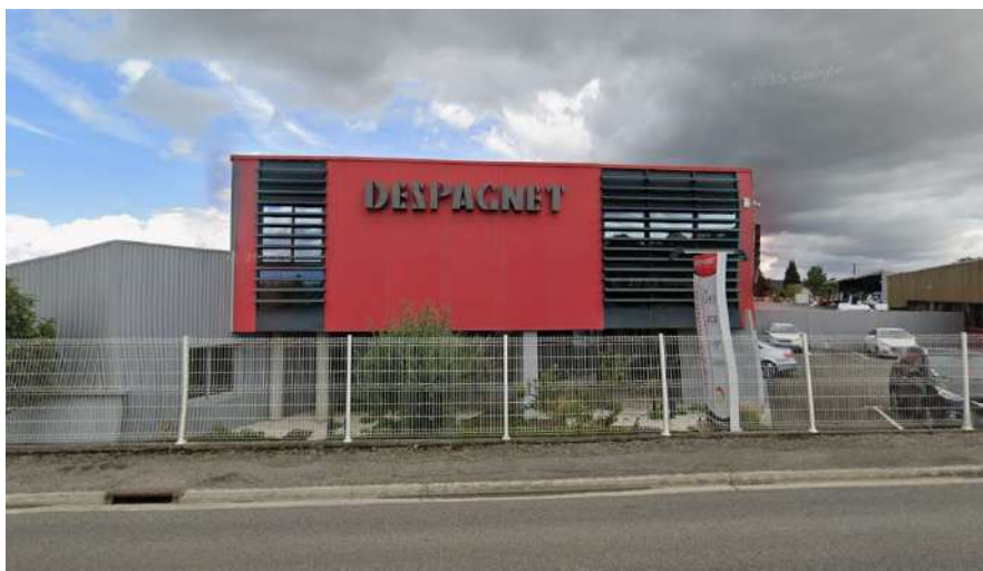
Entreprise Despagnet route de Nay
